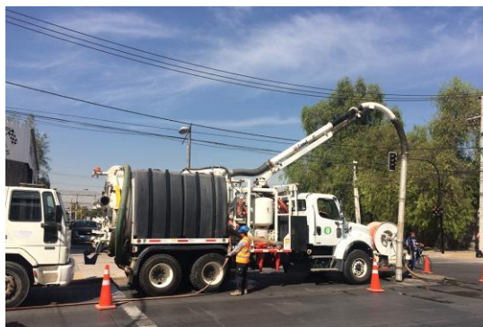
Mantenimiento colector Aguas Lluvias
